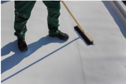
1 Oberfläche reinigen
