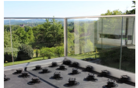
3 Vor dem Auslegen der Elefeet® Stelzlager die Höhe grob voreinstellen
