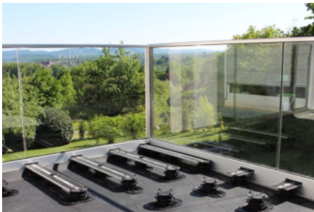
4 Zubehörteile je nach Randsituation einbauen
