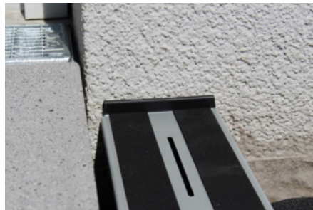
5 Als zusätzlichen Schutz der Fassade oder der Abdichtung kann ein Kantenschutz auf die Aufkantung der Zubehörteile aufgesetzt werden
