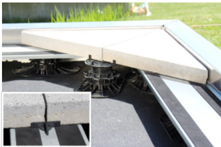
4.3 Gehrungs- und Randaufleger bei einer diagonalen Verlegung, schrägen Wandanschlüssen oder Rinnen verwenden. Zusätzliche Fugenkreuze beim Entfernen von Fugenteilern der Elefeet® Stelzlager verwenden
