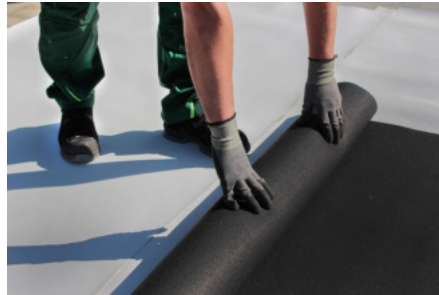
2 Elastosave ES 30 mit ca. 5 cm Überlap- pfung auslegen; nicht auf der Abdichtung schneiden
